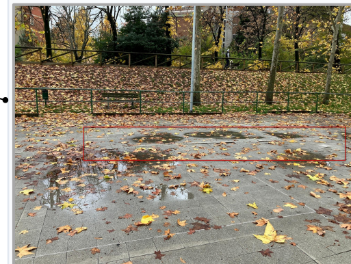
Pavimentazione sconnessa
