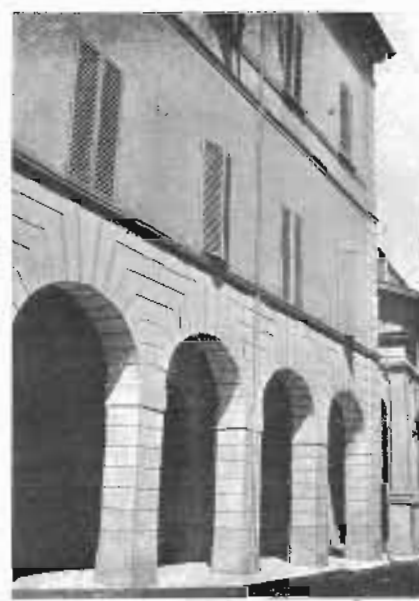
Casa abitata da Luigi Zamboni (fronte di Via Galliera).
