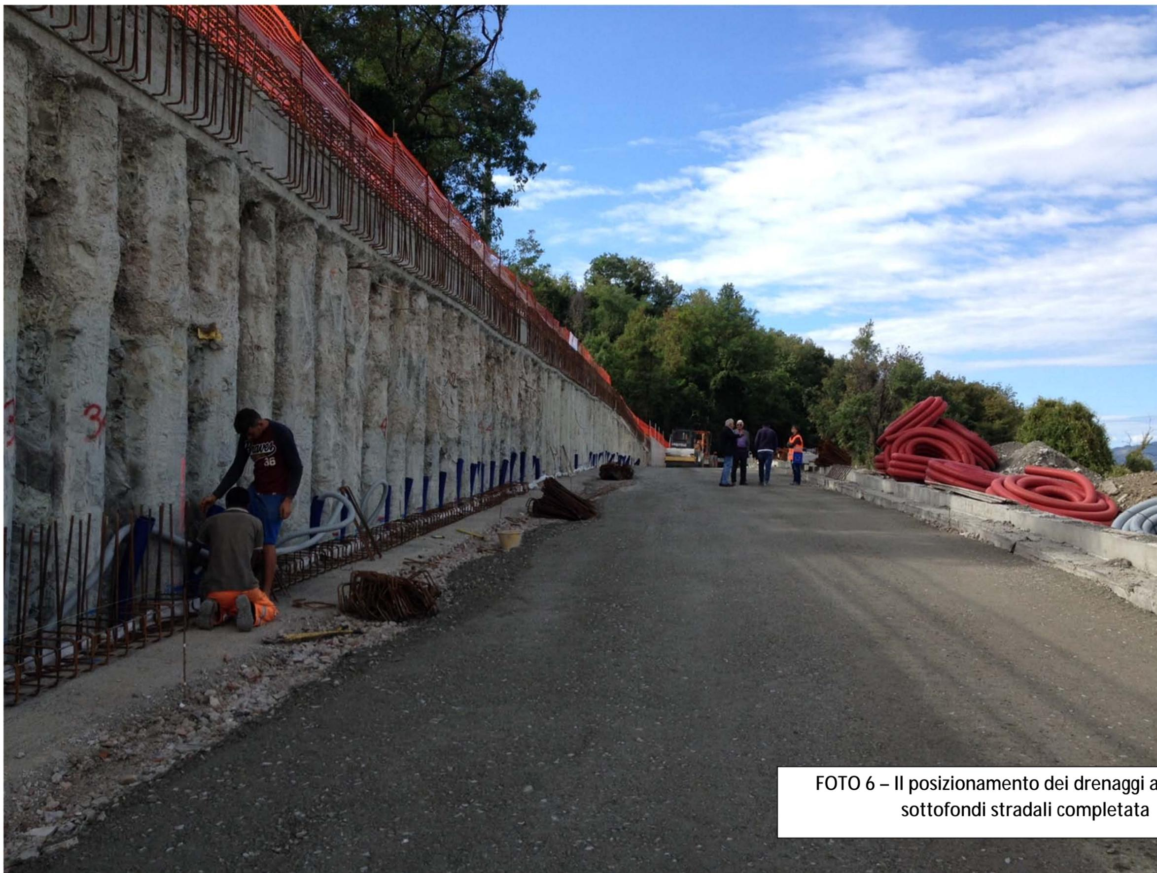
FOTO 6 – Il posizionamento dei drenaggi a stesa dei sottofondi stradali completata
