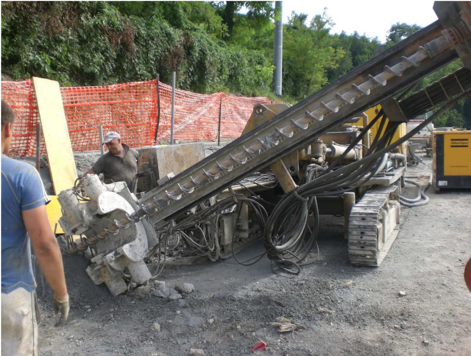
FOTO 3 – Esecuzione dei tiranti passivi della palificata di monte
