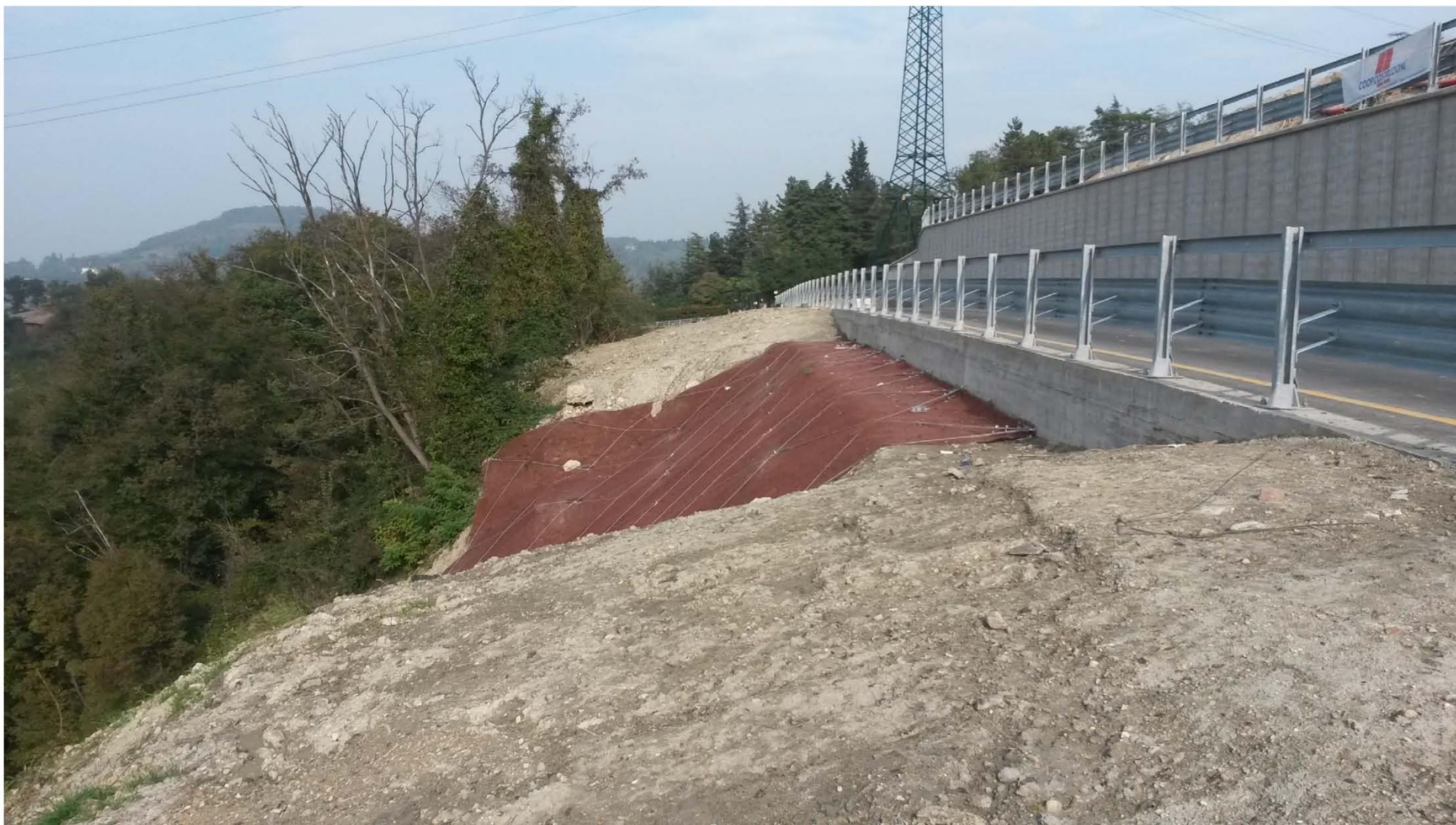
FOTO 11 – Il rafforzamento corticale per la protezione della nicchia di frana
