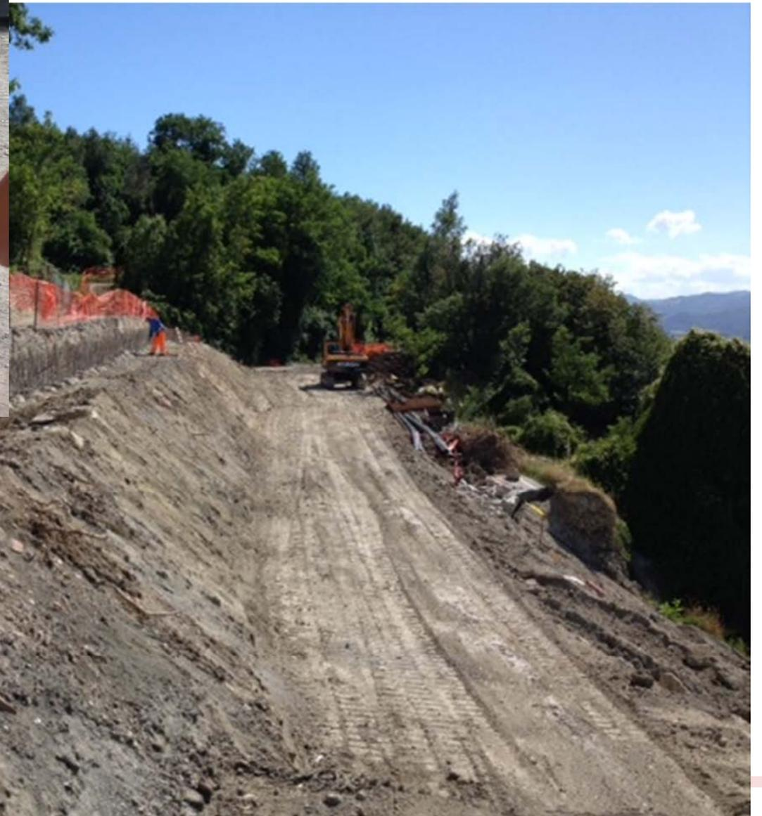
FOTO 4 – Sbancamento parziale della nuova sede stradale per permettere la maturazione dei pali di monte e la contestuale esecuzione di quelli di valle
