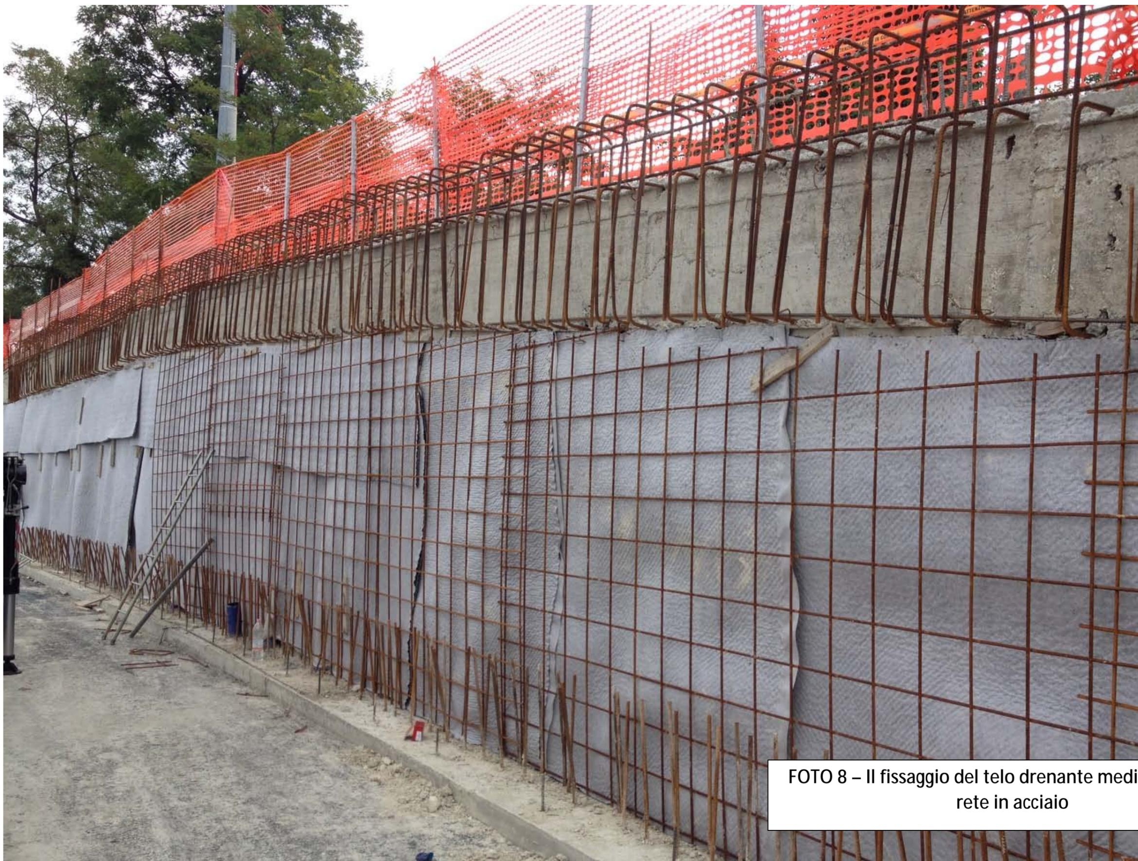
FOTO 8 – Il fissaggio del telo drenante mediante posa di rete in acciaio
