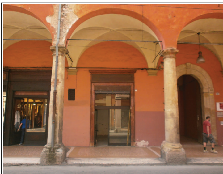
vista fronte strada - localizzazione immobile
