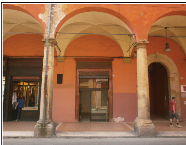
vista fronte strada - localizzazione immobile
