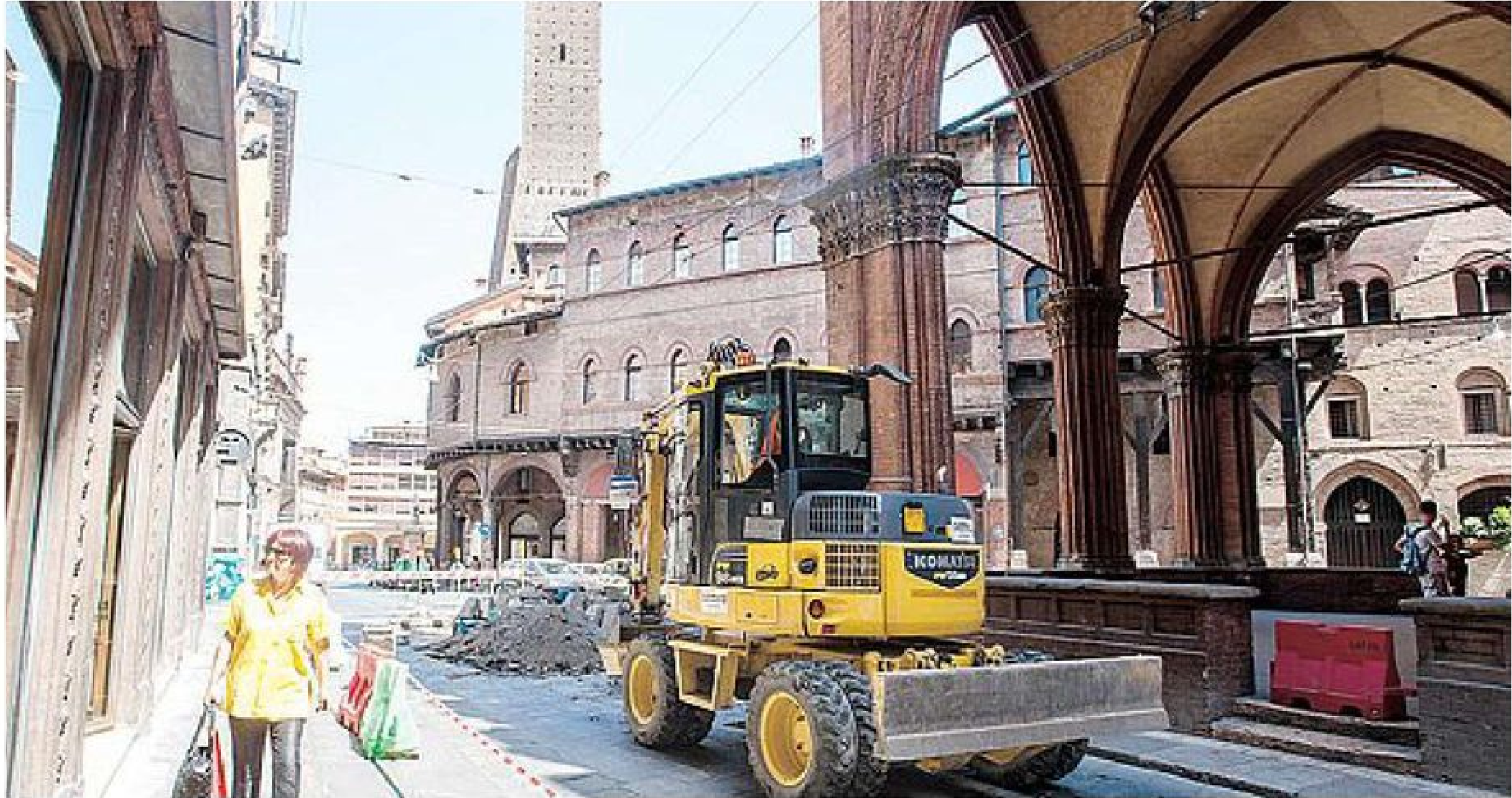
MOBILITÀ Ruspe al lavoro nel tratto di via Castiglione, nei pressi di piazza della Mercanzia
