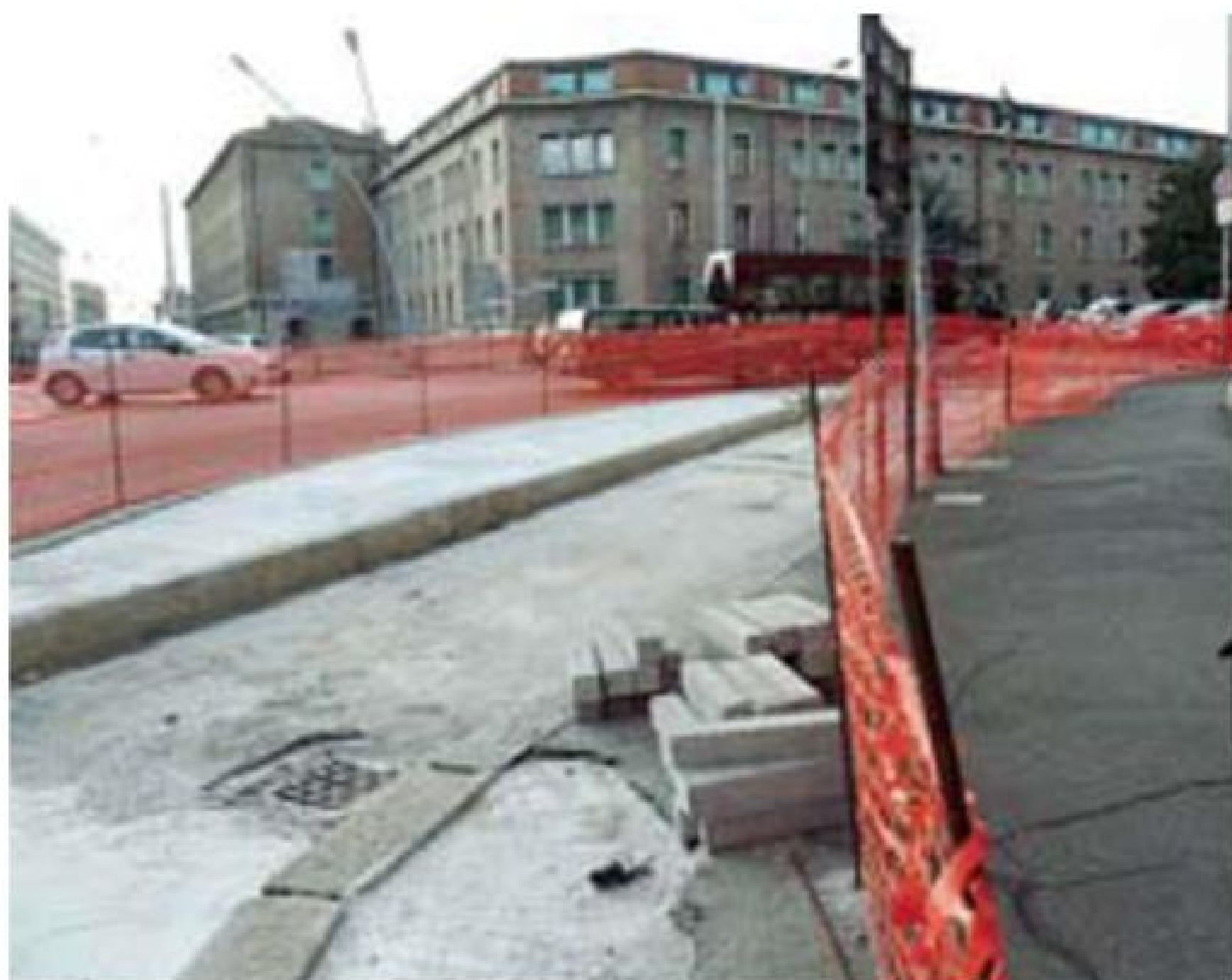
Il cantiere A Porta Galliera si lavora (ma non in mezzo al viale)
