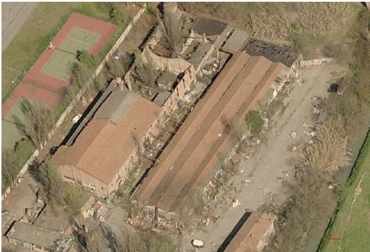
Foto 2 : esempio di area abbandonata che permette il riparo alla popolazione murina
