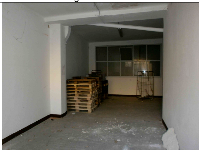
Interni Piano Terra Tubo smaltimento fumi caldaia
