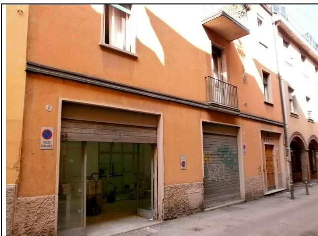
Fronte sulla Via Remorsella
