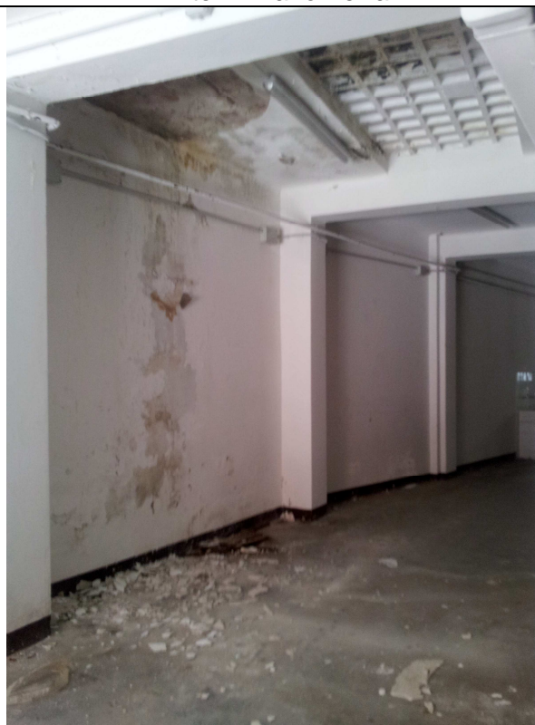
Interni Piano Terra Luce in vetrocemento
