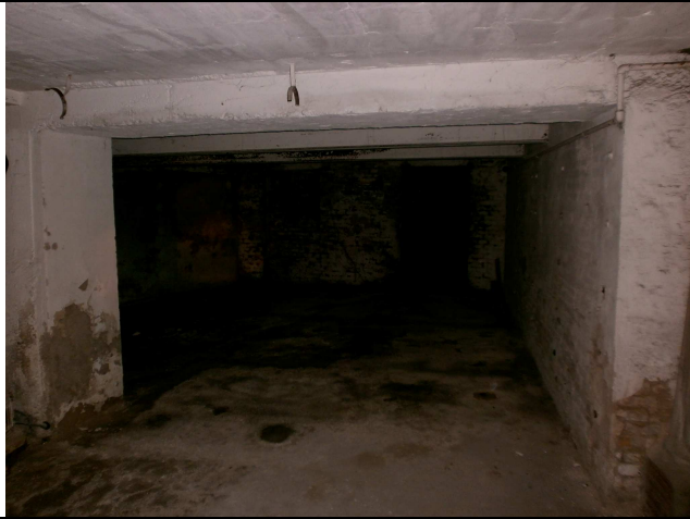
Interni Piano Interrato
