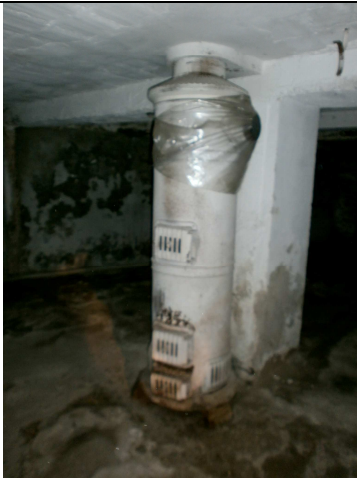
Piano Interrato Particolare caldaia
