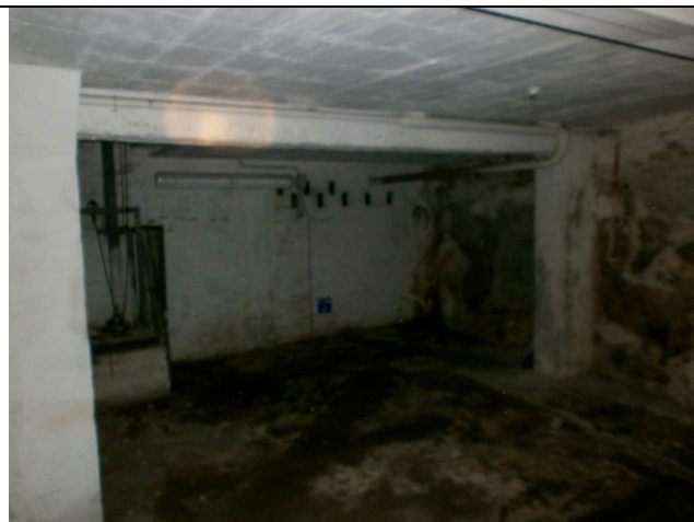
Interni Piano Interrato
