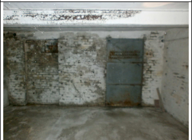
Interni Piano Interrato Accesso dal giardino
