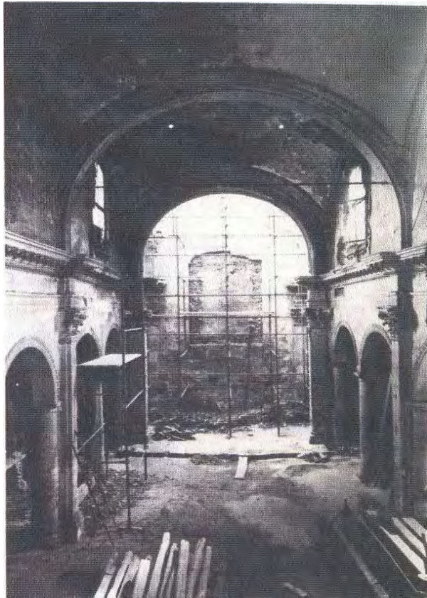
Lo spazio della navata centrale, coperta con le volte a vela nel 1960, come appariva nel corso dei lavori di ricostruzione post-bellica
