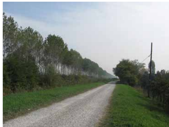
L'imbocco di Via Valle all'uscita di Malabergo, e la prosecuzione della strada sulla sommità dell'argine
