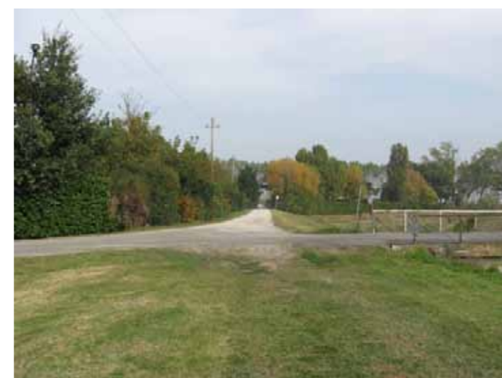
Il tracciato sulla sommità del Canale Botte, con le due passerelle (di cui una chiusa al transito), e la sterrata di collegamento al percorso lungo il Navile (in proprietà privata)
