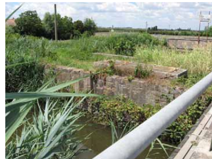
L'attraversamento della S.P. di Altedo, l'avvio del percorso adiacente l'ex Zuccherificio, i manufatti spondali del Navile a valle del ponte sulla strada provinciale
