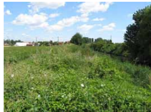
Una strada carrabile lungo la sponda del canale (Via Ponticelli a Malalbergo) e la sommità arginale, a tratti non praticabile e rivestita di vegetazione (presso il nucleo Paleotto a Bentivoglio)
