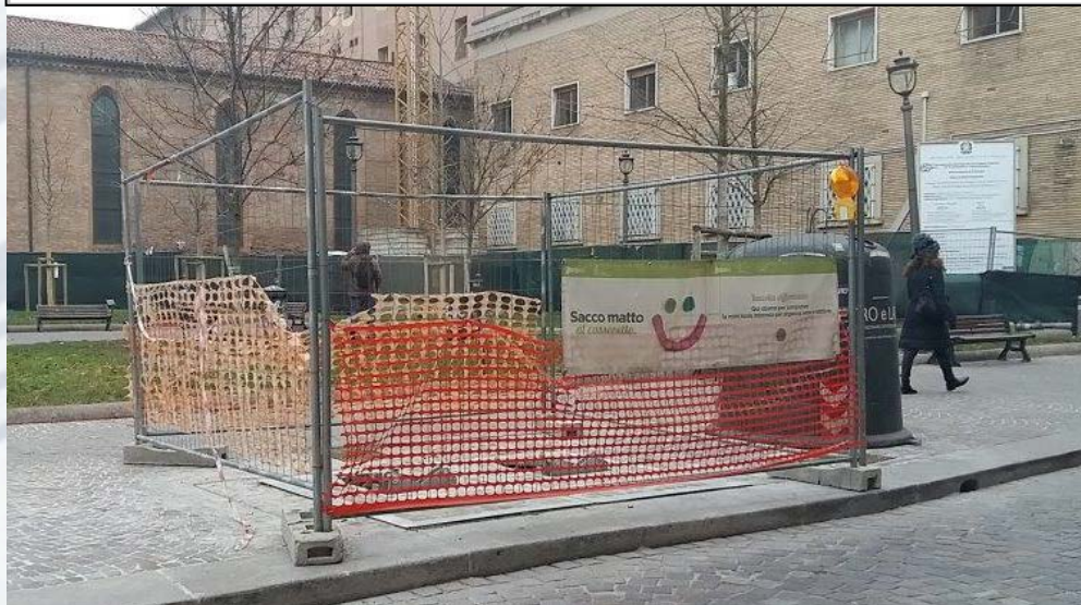
In alto: cartello di cantiere Sopra: cantiere di Via De' marchi - Piazza S.Francesco A destra: cartello di cantiere
