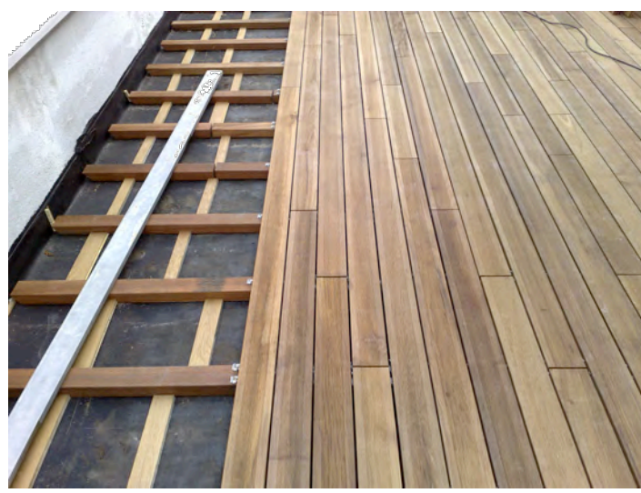
esempio di pavimentazione in doghe di legno di larice posata su struttura con magatelli in legno ancorati al terreno
