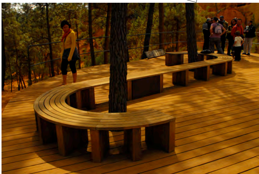
esempio di pavimentazione in doghe di legno di larice posata su struttura con magatelli in legno ancorati al terreno
