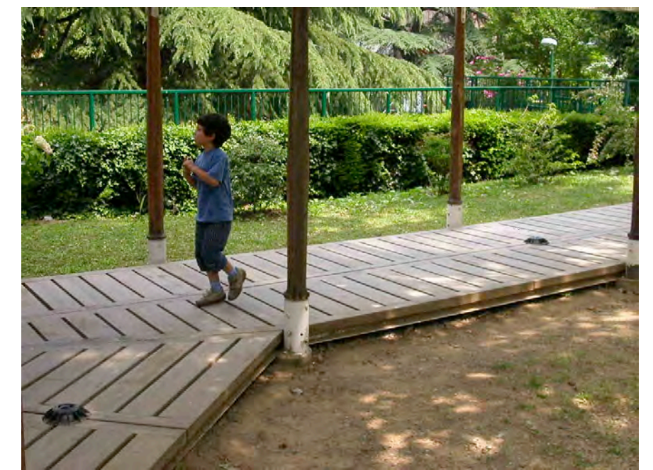
esempio di pavimentazione in doghe di legno di larice posata su struttura con magatelli in legno ancorati al terreno
