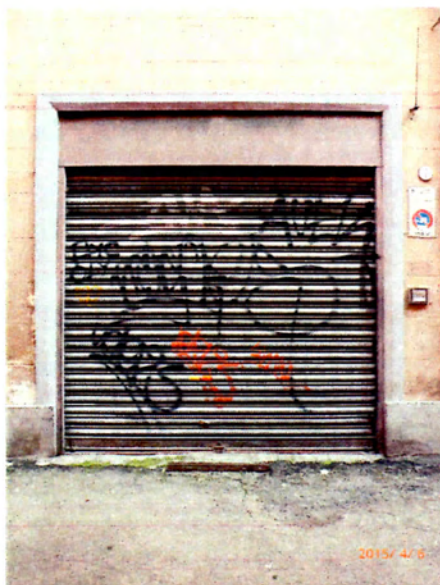
Stato Precedente l'intervento
