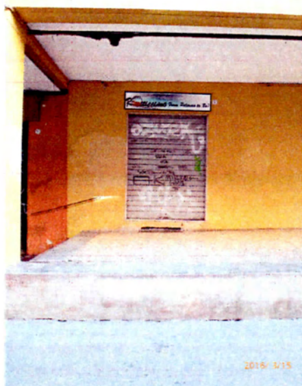
Stato Precedente l'intervento
