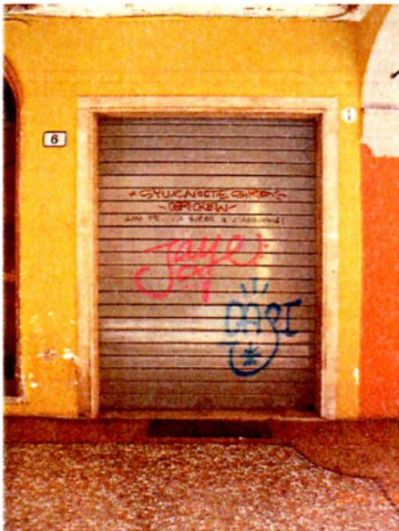
Stato Precedente l'intervento
