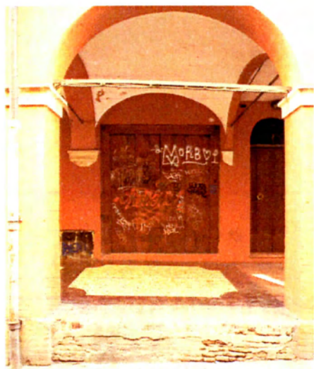
Stato Precedente l'intervento
