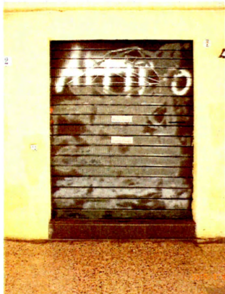
Stato Precedente l'intervento
