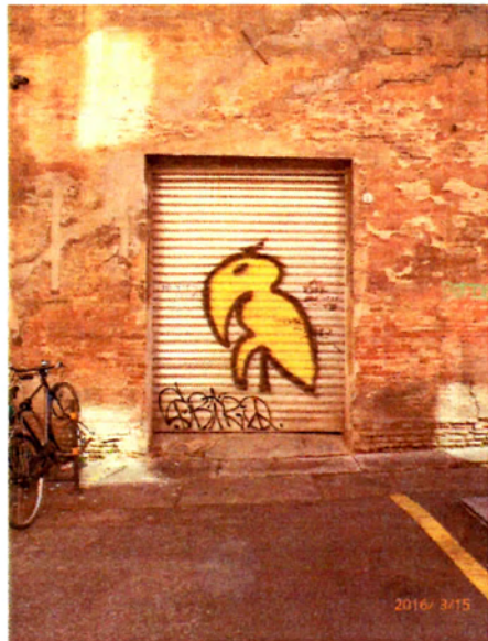
Stato Precedente l'intervento
