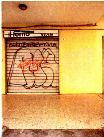
Stato Precedente l'intervento
