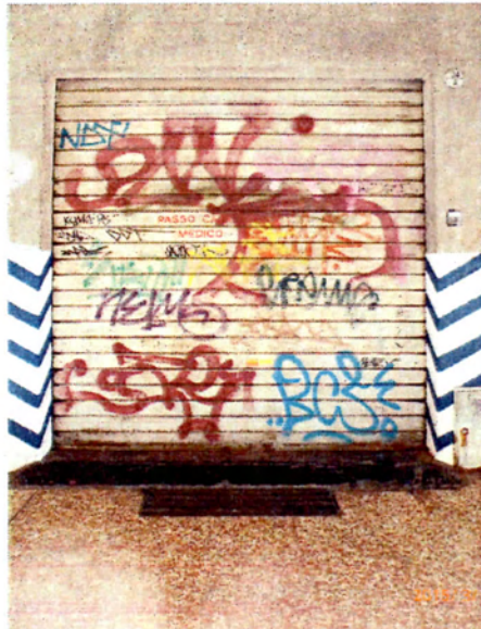
Stato Precedente l'intervento
