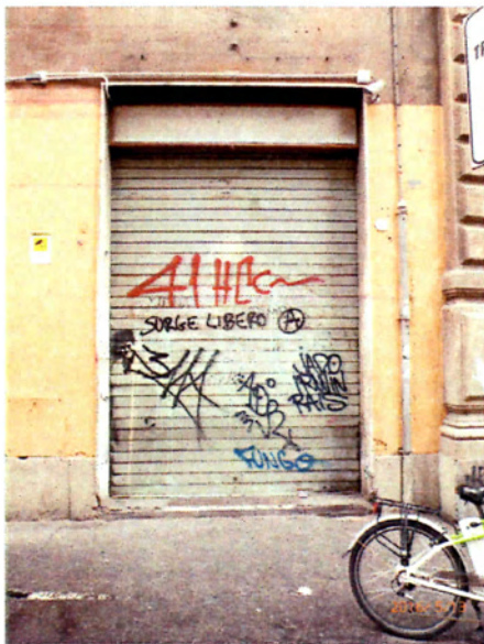
Stato Precedente l'intervento
