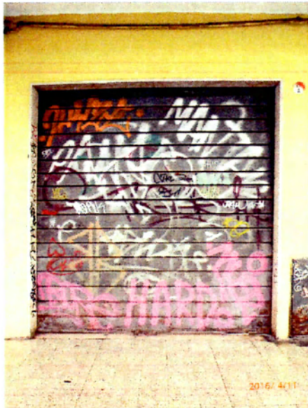
Stato Precedente l'intervento
