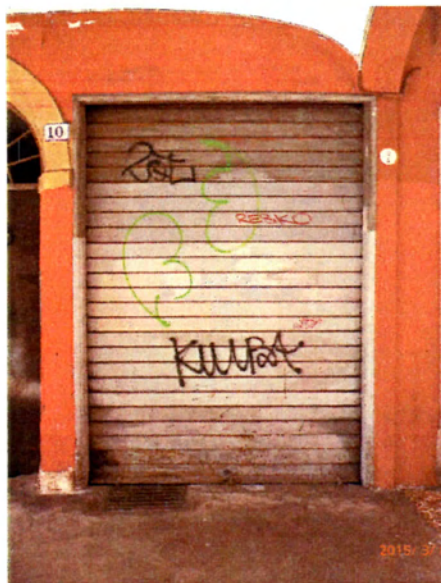
Stato Precedente l'intervento
