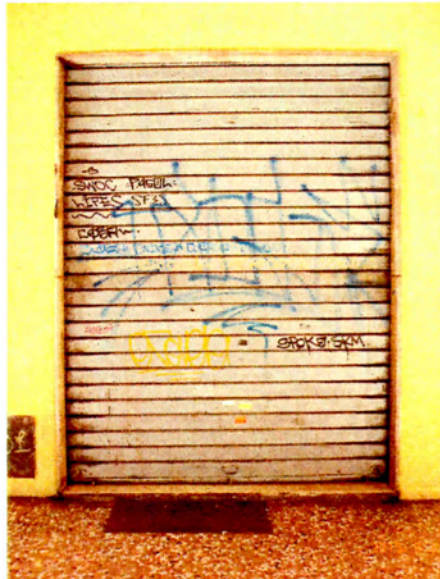
Stato Precedente l'intervento
