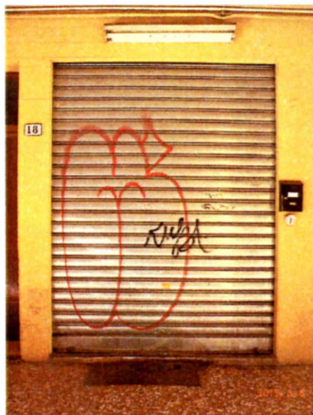
Stato Precedente l'intervento
