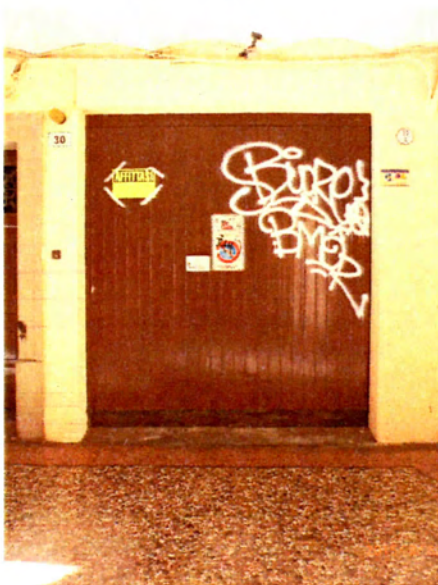
Stato Precedente l'intervento
