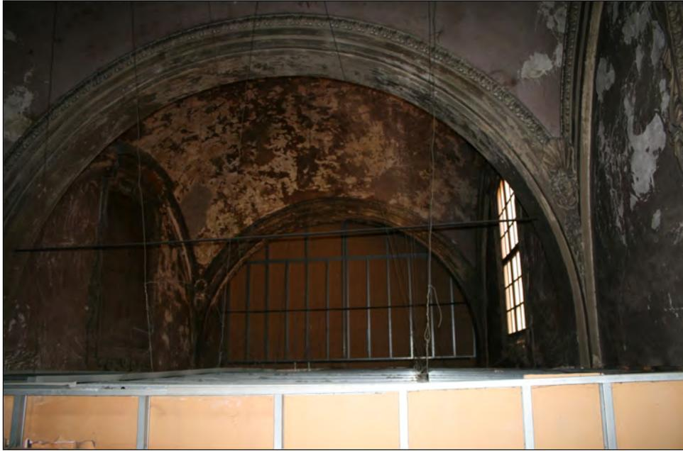
24\_Particolare di una delle volte a vela che coprono la navata centrale della ex-chiesa di San Leonardo, attualmente celate da un controsoffitto di cui si prevede la rimozione.
