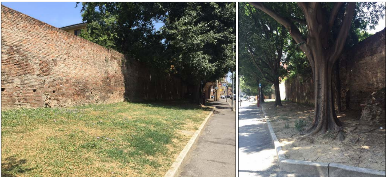
Foto dell'area verde di Via Boldrini prima dell'intervento
