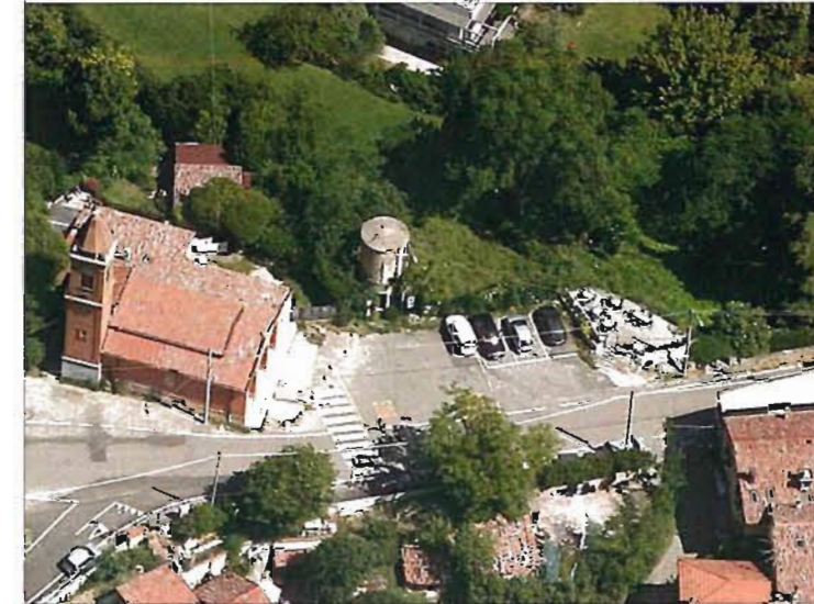
VEDUTA AEREA DEL TORRINO PIEZOMETRICO
