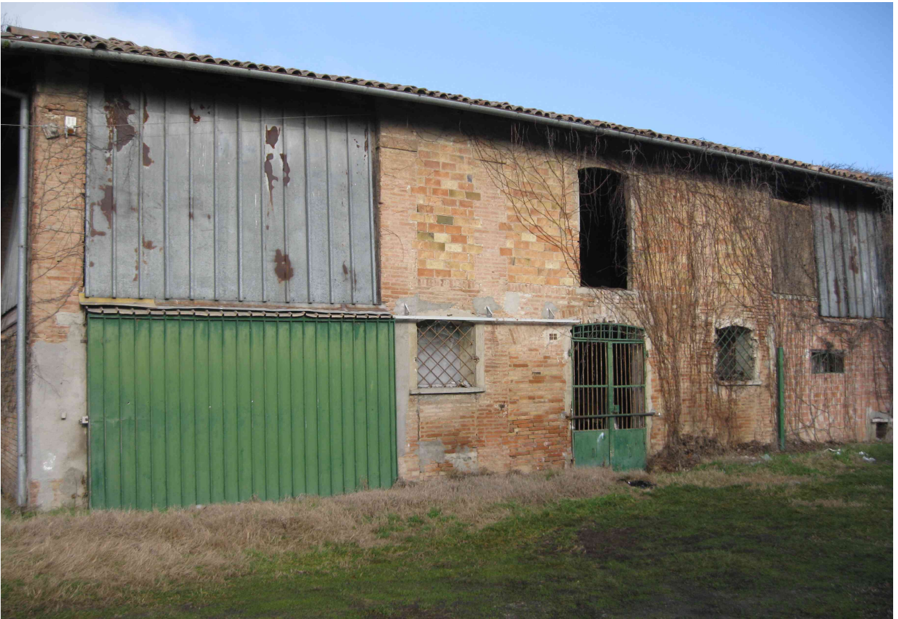
3) Edificio B (ex stalla)
