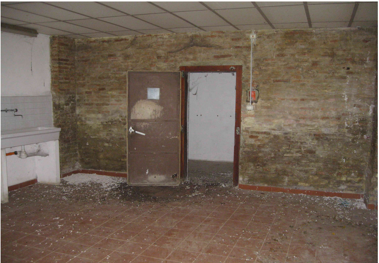
7) Edificio C. Interno
