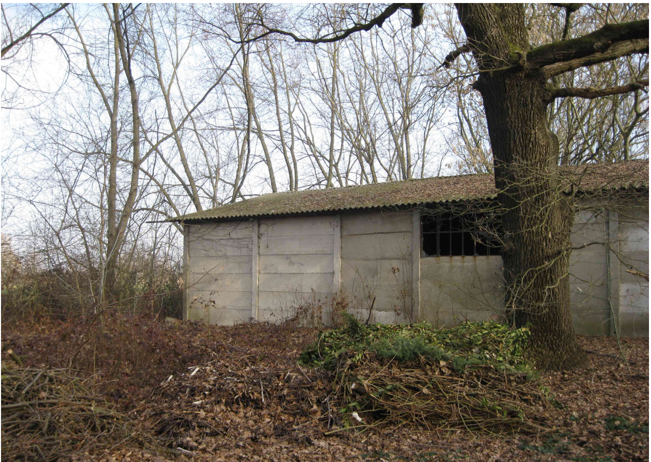
8) Edificio D (deposito attività industriali)
