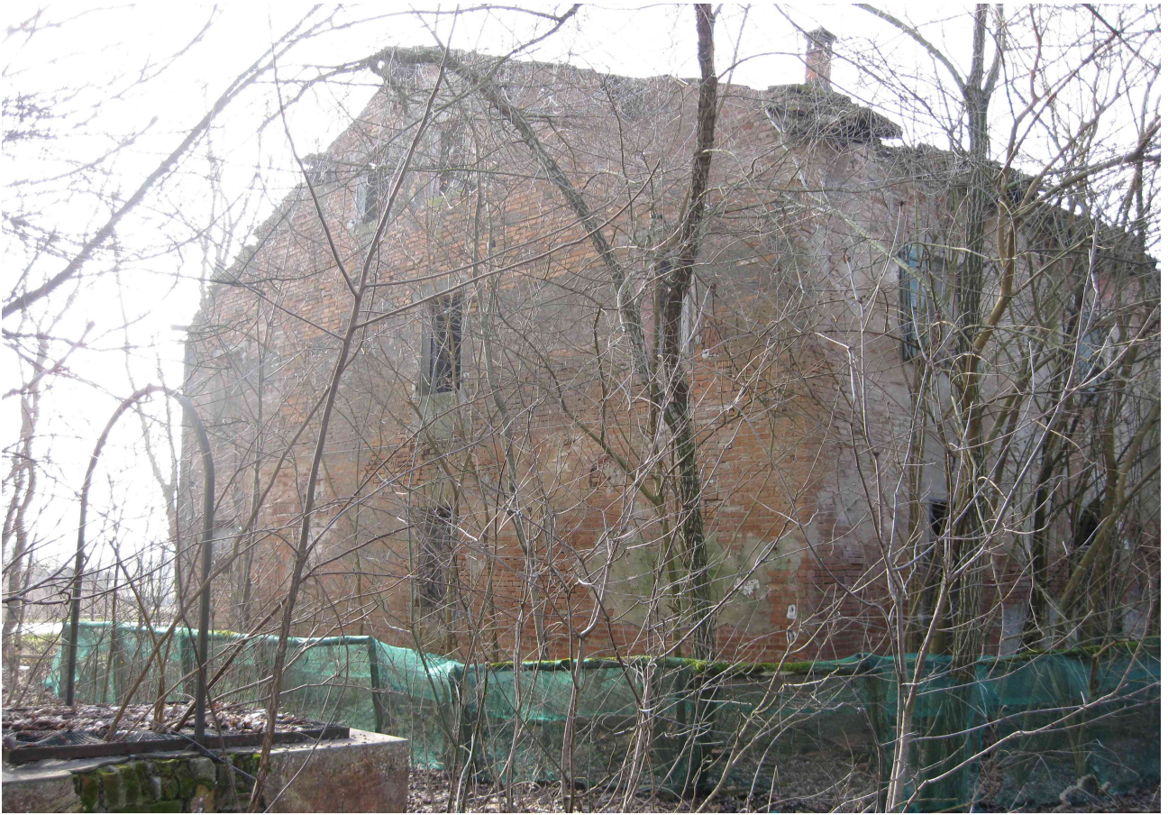
1) Edificio A – Ex casa colonial
