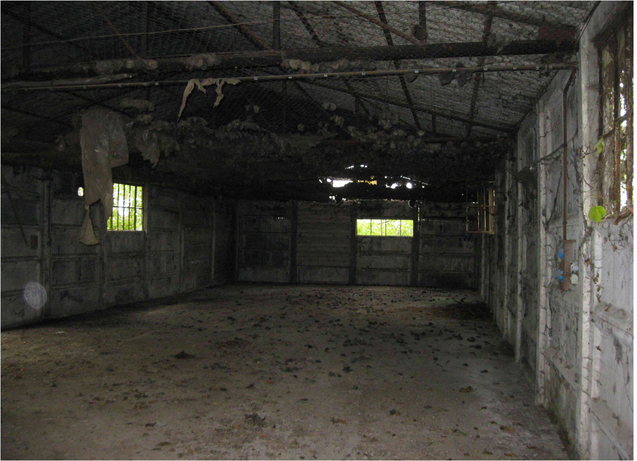
9) Edificio D. Interno
