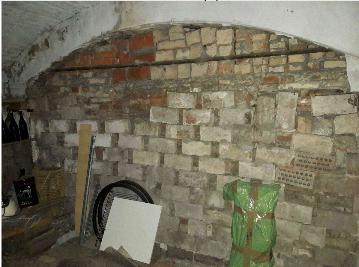
21. Vista interna della cantina di proprietà comunale - particolare struttura portante
