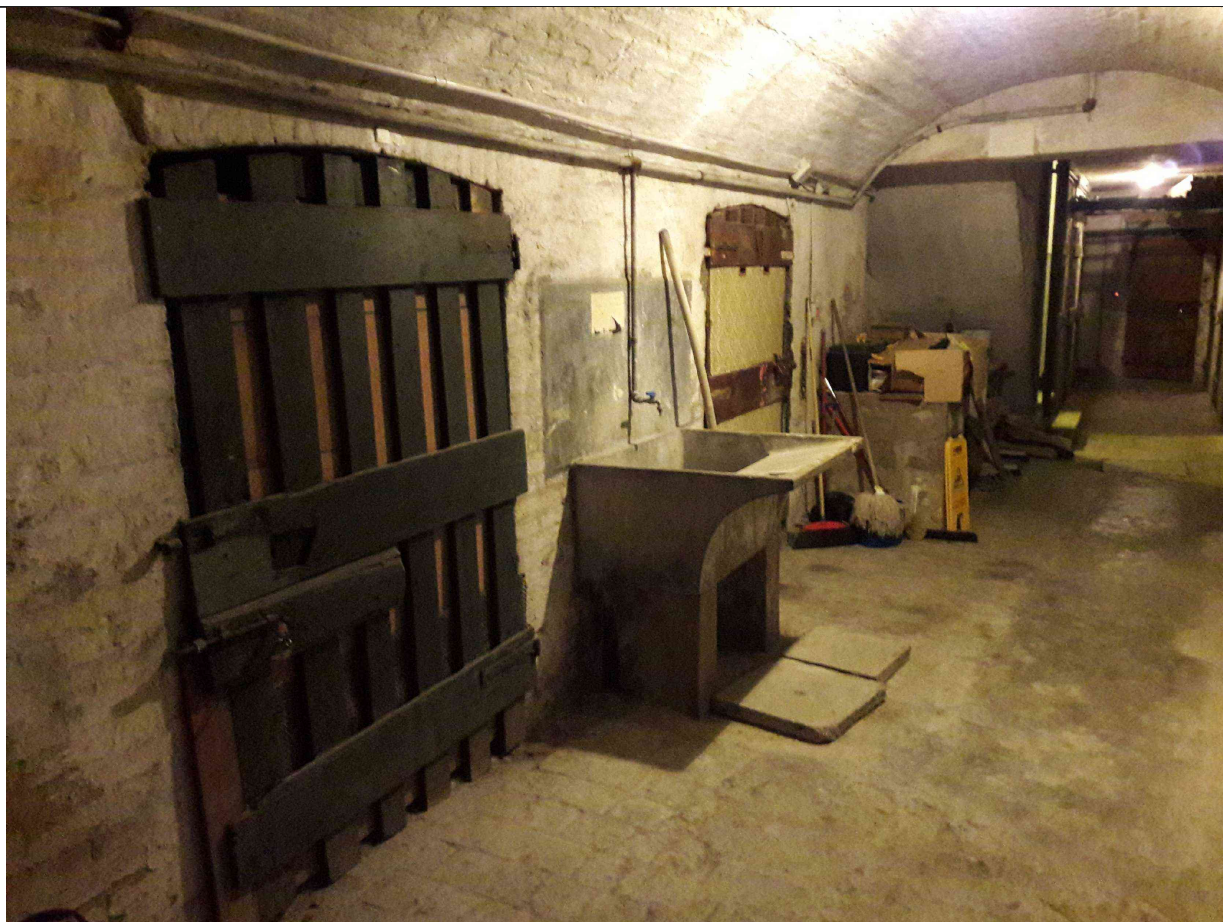
18. Accesso alla cantina di proprietà comunale - nucleo originario dell'edificio
