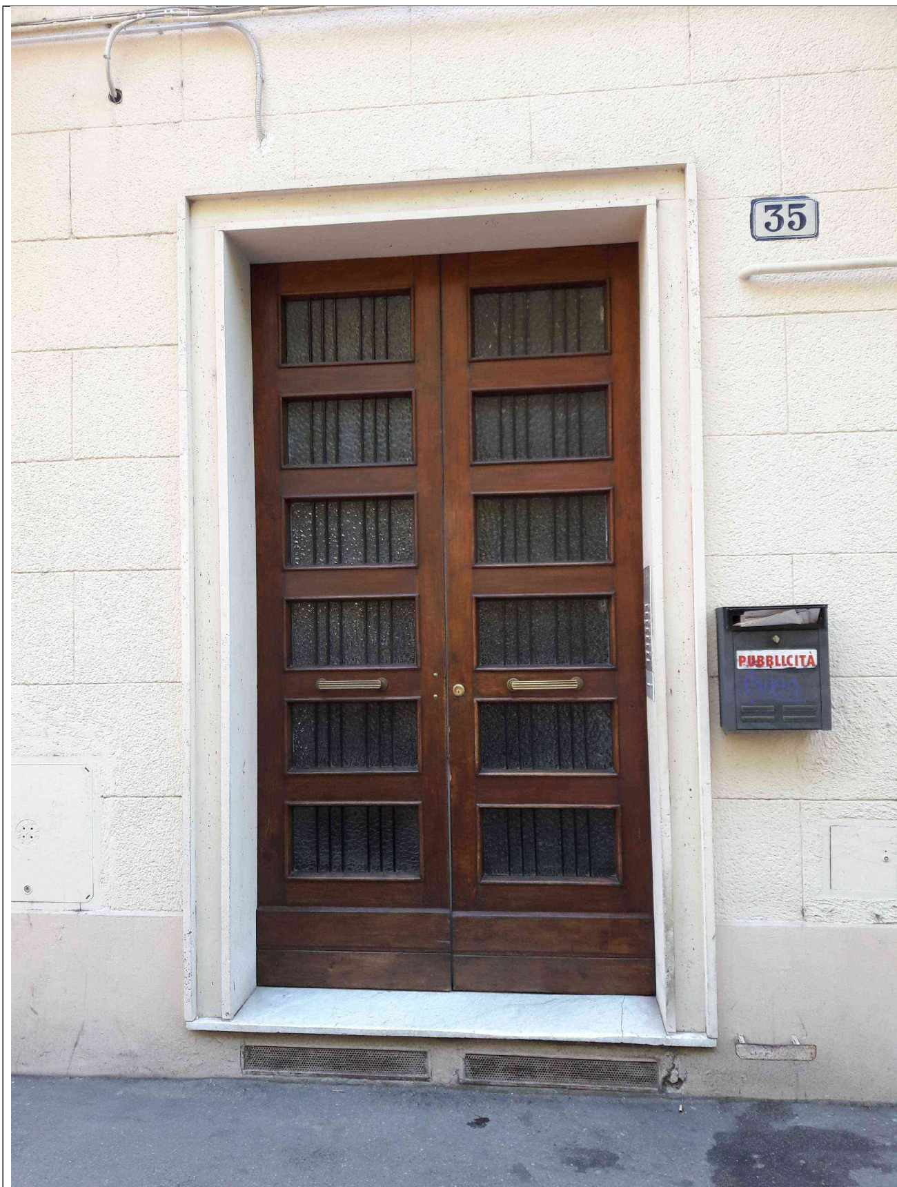
4. Accesso all'edificio sul fronte nord-ovest
