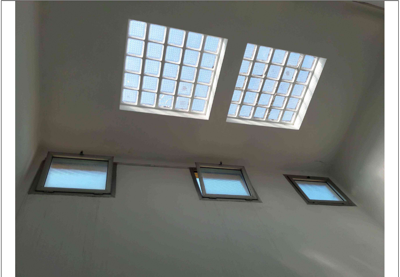
4. Soffitto vano scale
