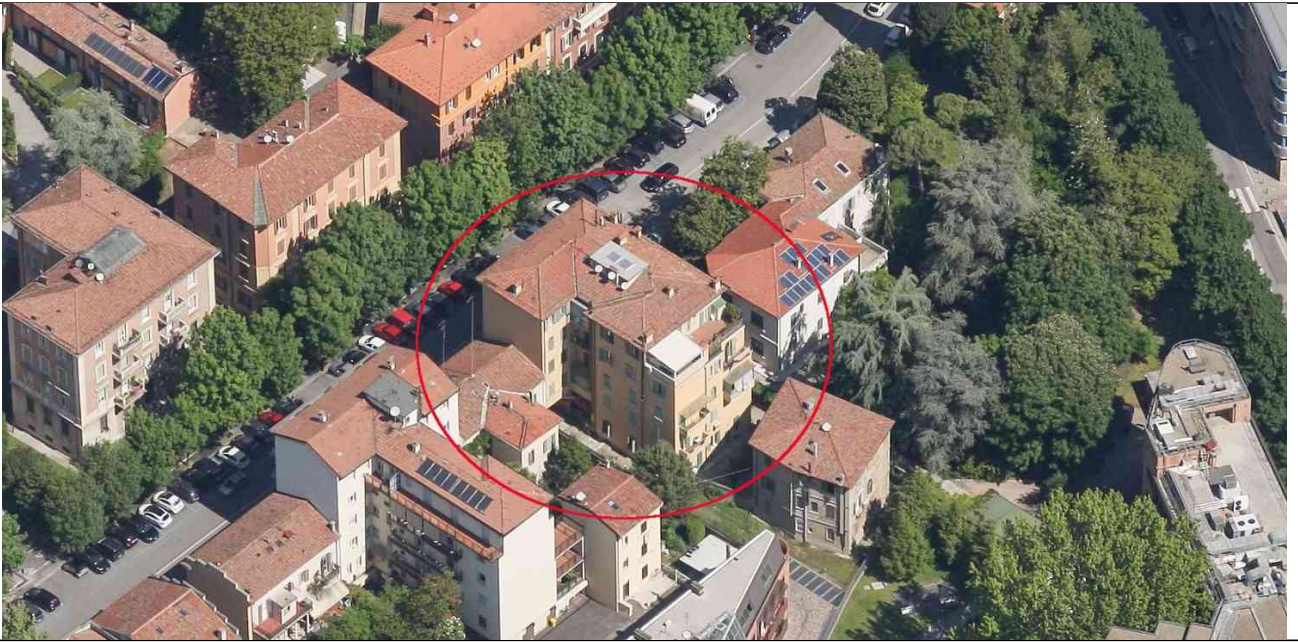
1. Vista aerea da sud
