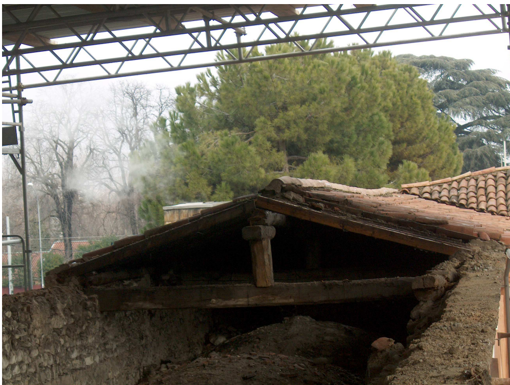
TIPOLOGIA DI COPERTURA ESISTENTE E MURATURA DEI PARAMENTI MURARI IN PIETRE ARROTONDATE E MALTA DI CALCE.
