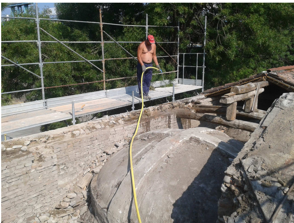
tipologia di paramento e volta a cupola tipo del porticato "1"
