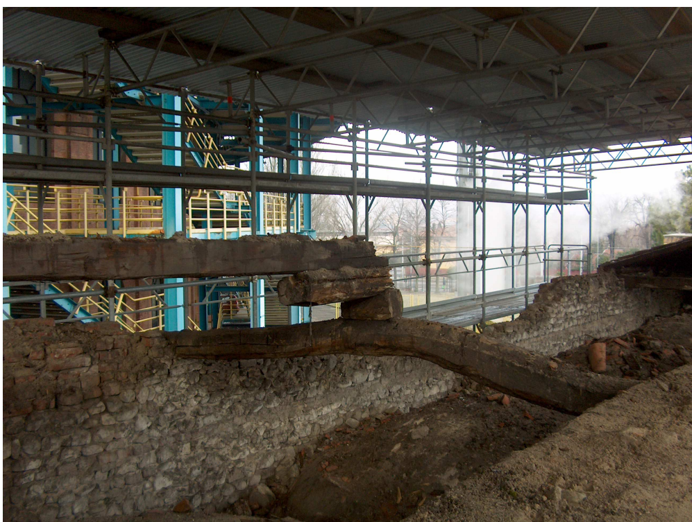
DETTAGLIO DI STRUTTURA DI COPERTURA DEL PORTICATO.
