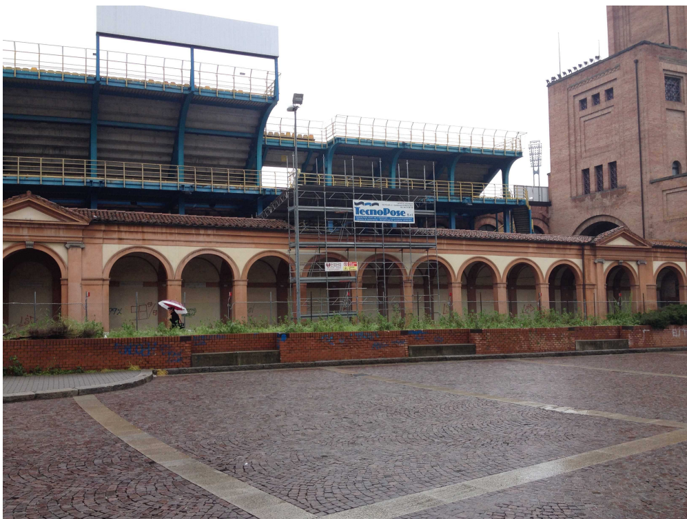
TRATTO DEL PORTICO OGGETTO DI INTERVENTO PROVVISORIO N.53-56
