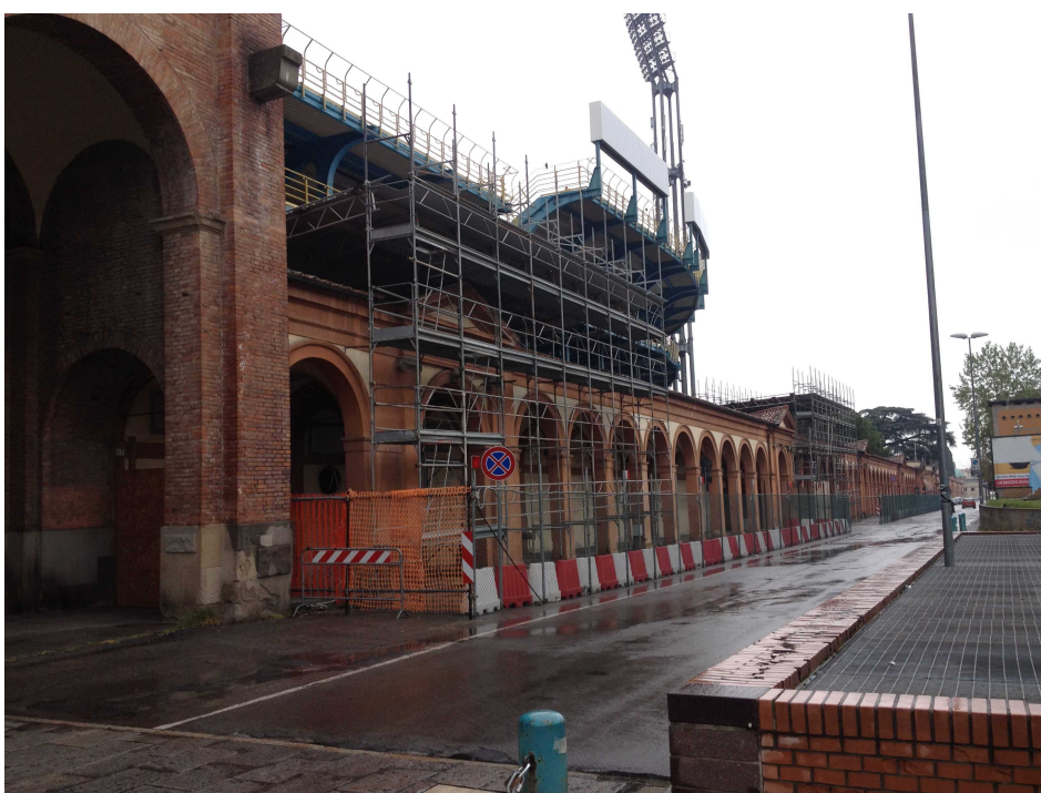
TRATTO DEL PORTICO OGGETTO DI
