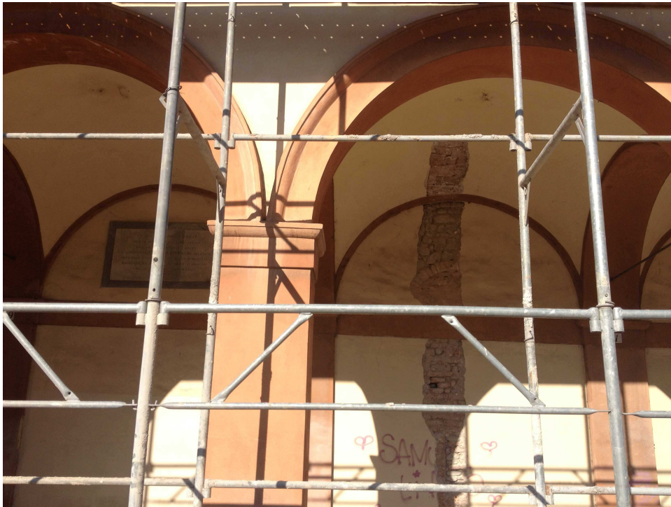
SAGGIO DI CARATTERIZZAZIONE DEI MATERIALI STRUTTURALI TIPO
