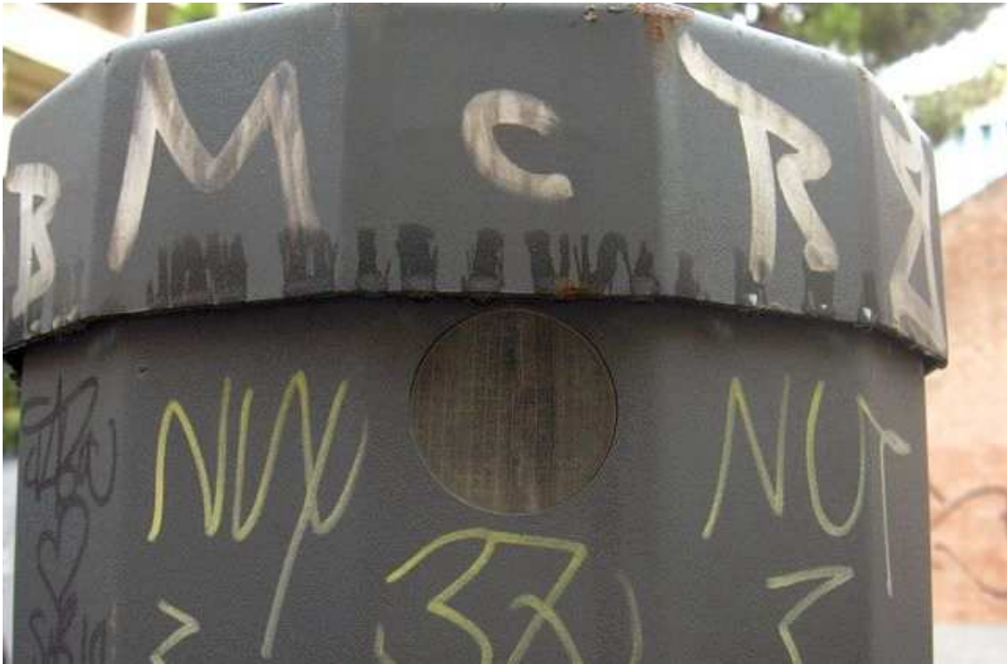
Figura 5: esempio di predisposizione per telecamera interna su "colonnina" (Moline/Mentana – entrata)
