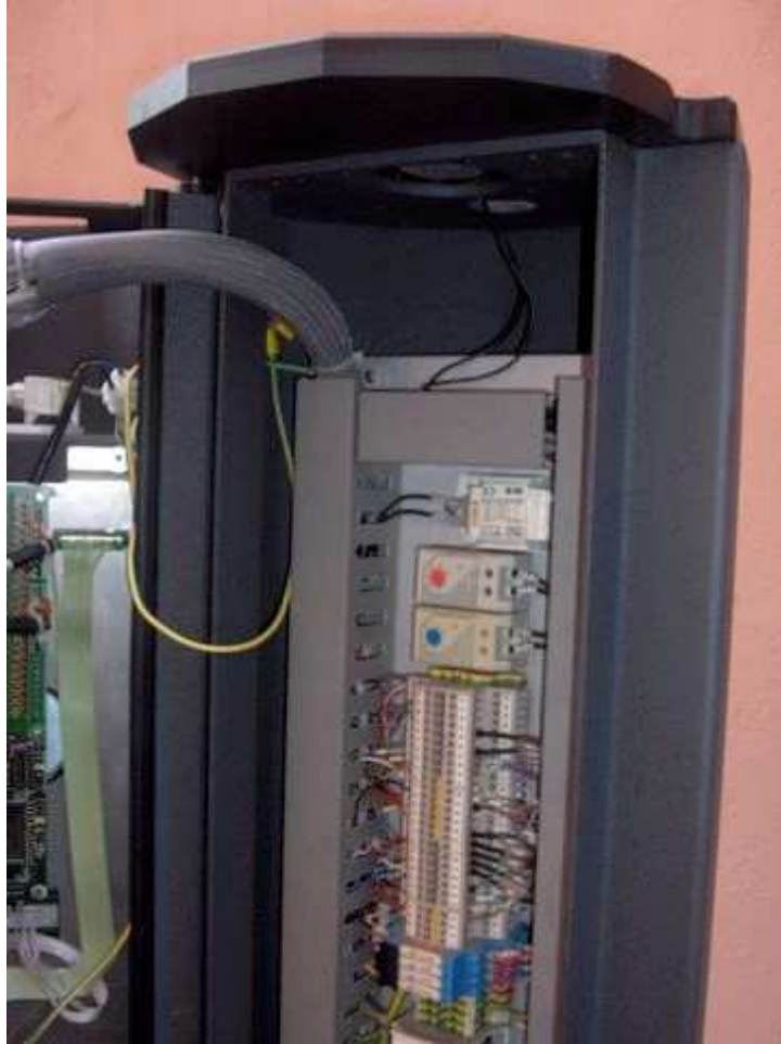
Figura 16: zoom esempio parte alta interno "colonnina" (Pietralata/S. Isaia – entrata)
