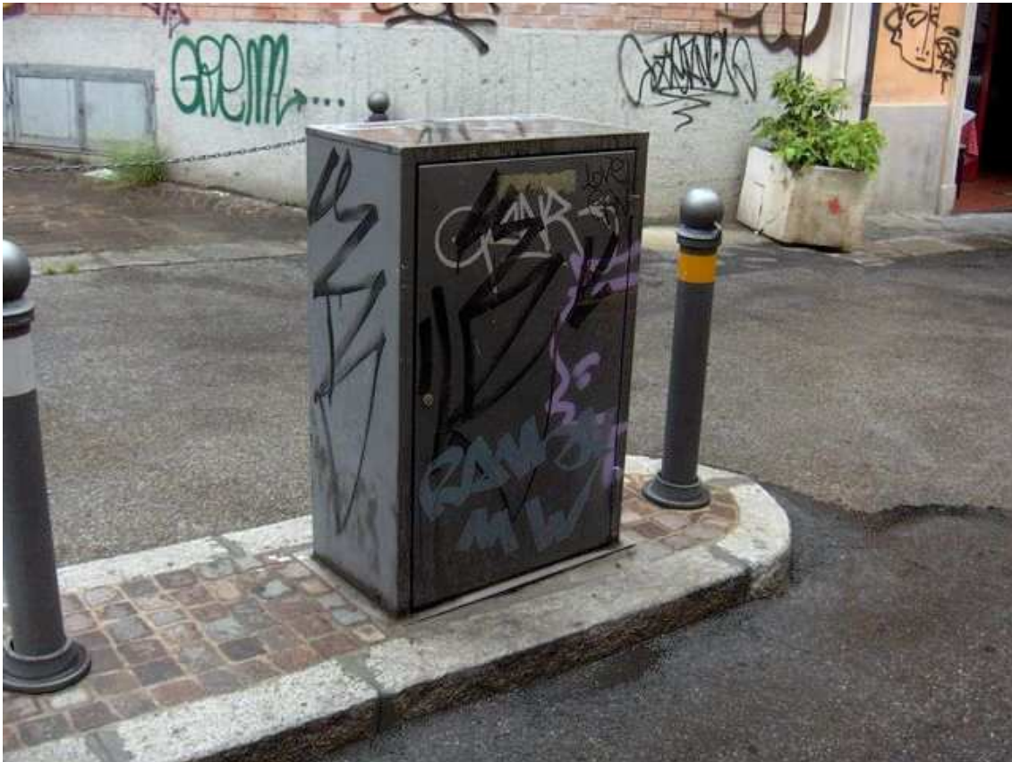
Figura 4: esempio di quadro elettrico e di elettronica di potenza del Pilomat (Moline/Mentana – entrata)
