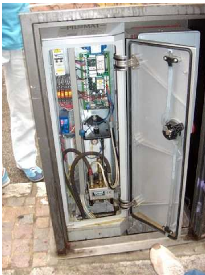
Figura 12: esempio interno quadro Pilomat (Moline/Mentana – entrata)
