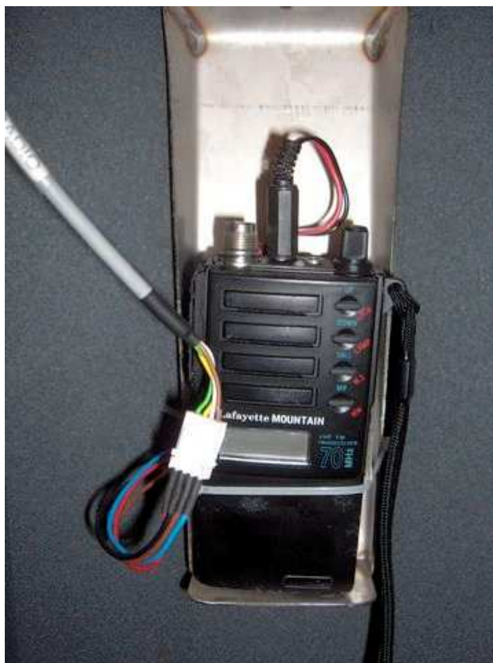
Figura 20: zoom esempio di radio per i VVFF all'interno della colonna (Pietralata/S. Isaia - entrata)
