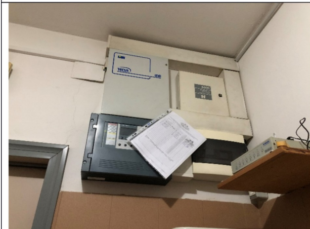
Centralina impianto rilevazione fumi
