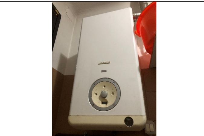
Caldaia riscaldamento a pavimento
