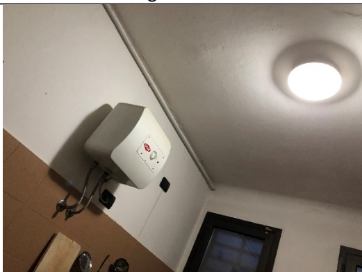
Boiler elettrico bagno disabili
