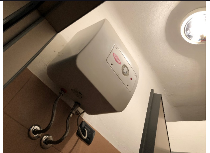
Boiler elettrico antibagno donne
