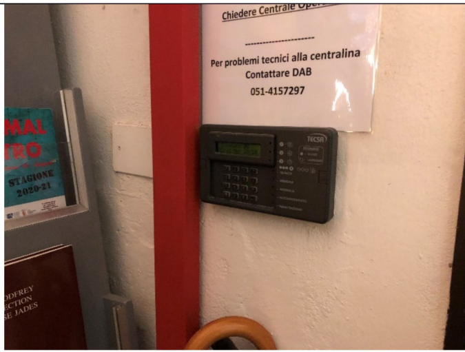
Centralina allarme antintrusione
