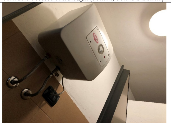
Boiler elettrico antibagno uomini
