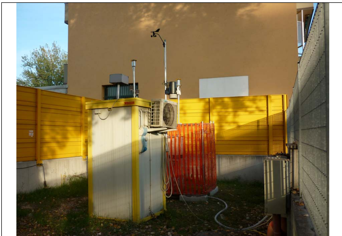
Figura 2–Le postazioni installate nell'area del campo base di Astaldi in via de' Carracci.
