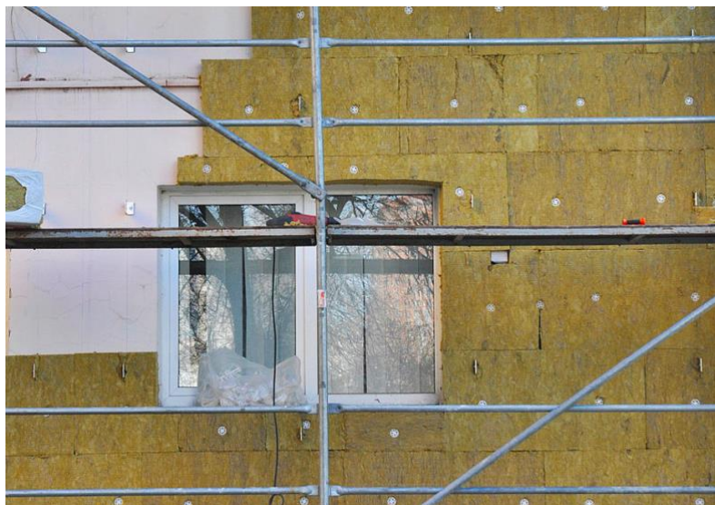
3. Esempio di cappotto termico su un edificio
