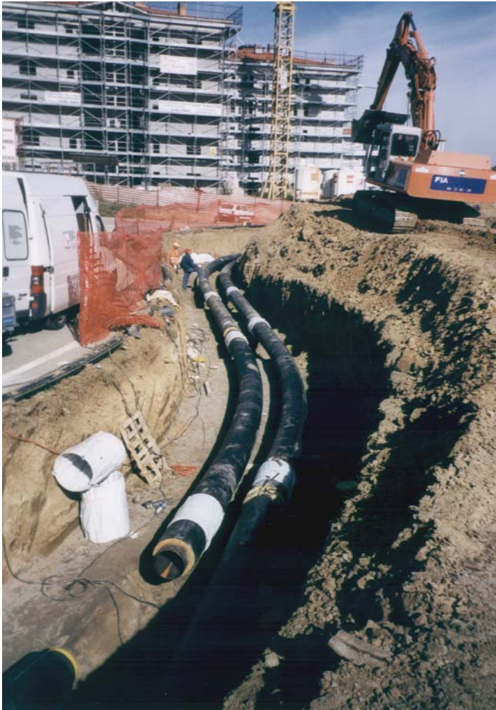
Posa tubazioni precoibentate (Sistema Ecocity - Comune di Casalecchio)
