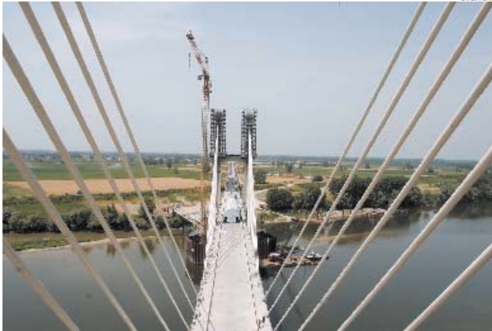
Ponte sospeso sul Po. I lavori a San Rocco al Porto (Lo) per l'alta velocità ferroviaria tra Milano e Bologna
